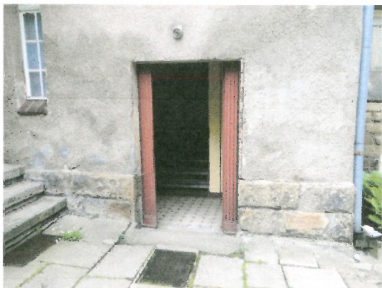
Wejście na klatkę schodową do lokalu nr 9 z tylnej strony budynku
