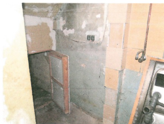
Widok na zdemontowany zlewozmywak w kuchni
