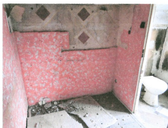
Widok ściany kuchni i wejście do w.c.
